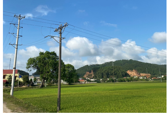
Tuyến đường điện hiện trạng đi qua dự án
