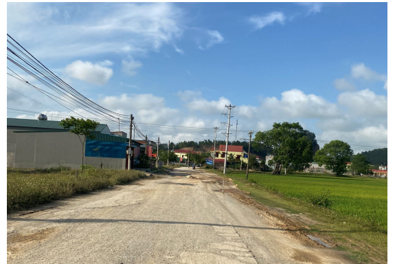
Tuyến đường hiện trạng phía Tây dự án
