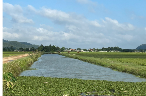
Tuyến mương hiện trạng phía Nam dự án
