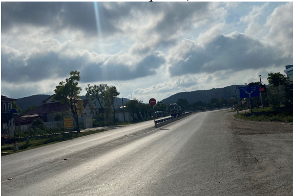
Tuyến đường hiện trạng phía Nam dự án
